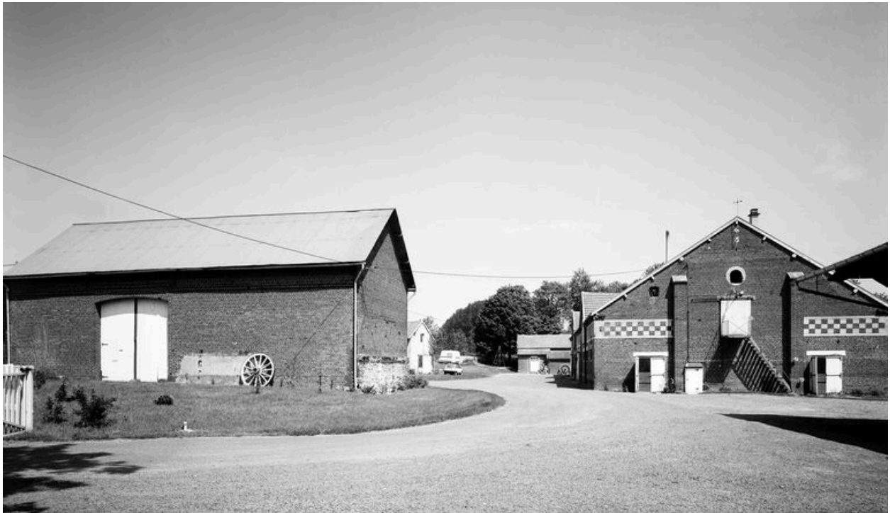
Ferme. Vue générale.
