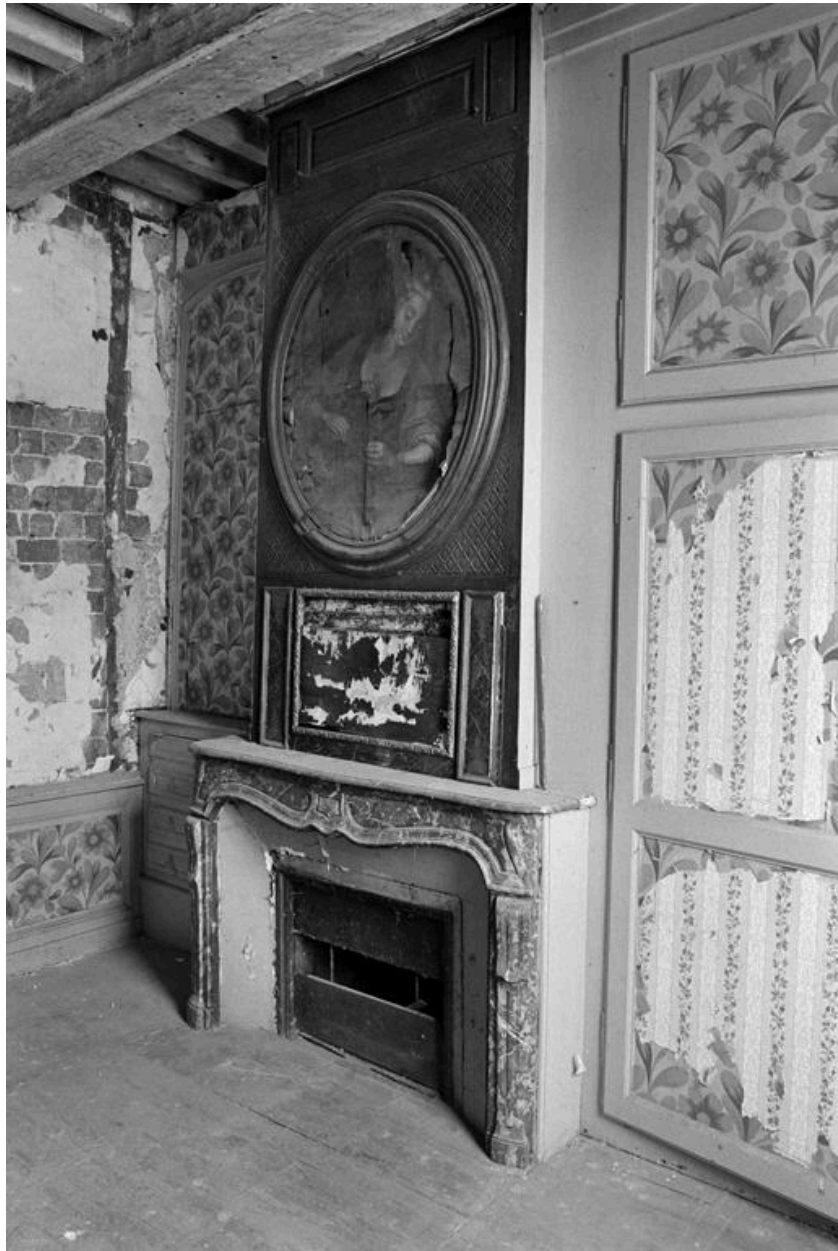
Vue du trumeau de cheminée du salon du rez-de-chaussée ; photographie prise en situation avant restauration de la pièce.
