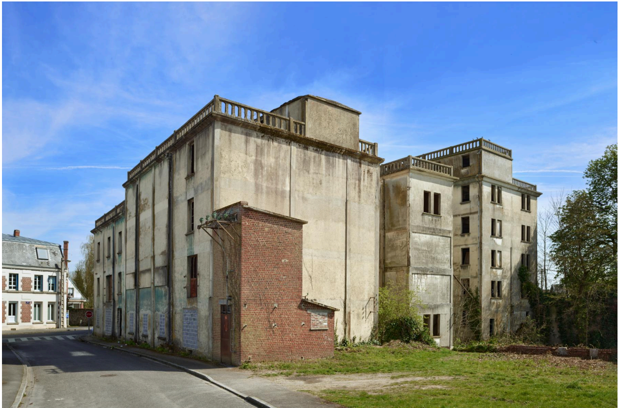
Vue d'ensemble de la minoterie depuis le nord-ouest.
