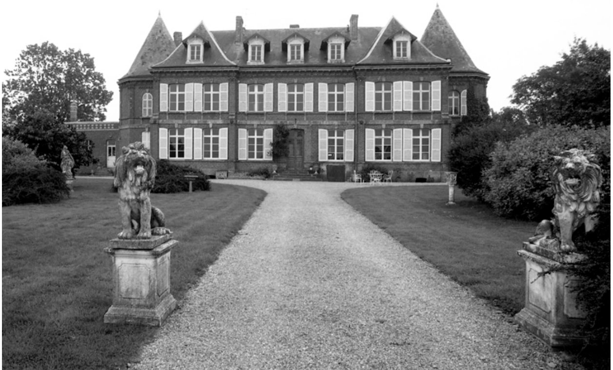
Vue d'ensemble de la façade du logis.
