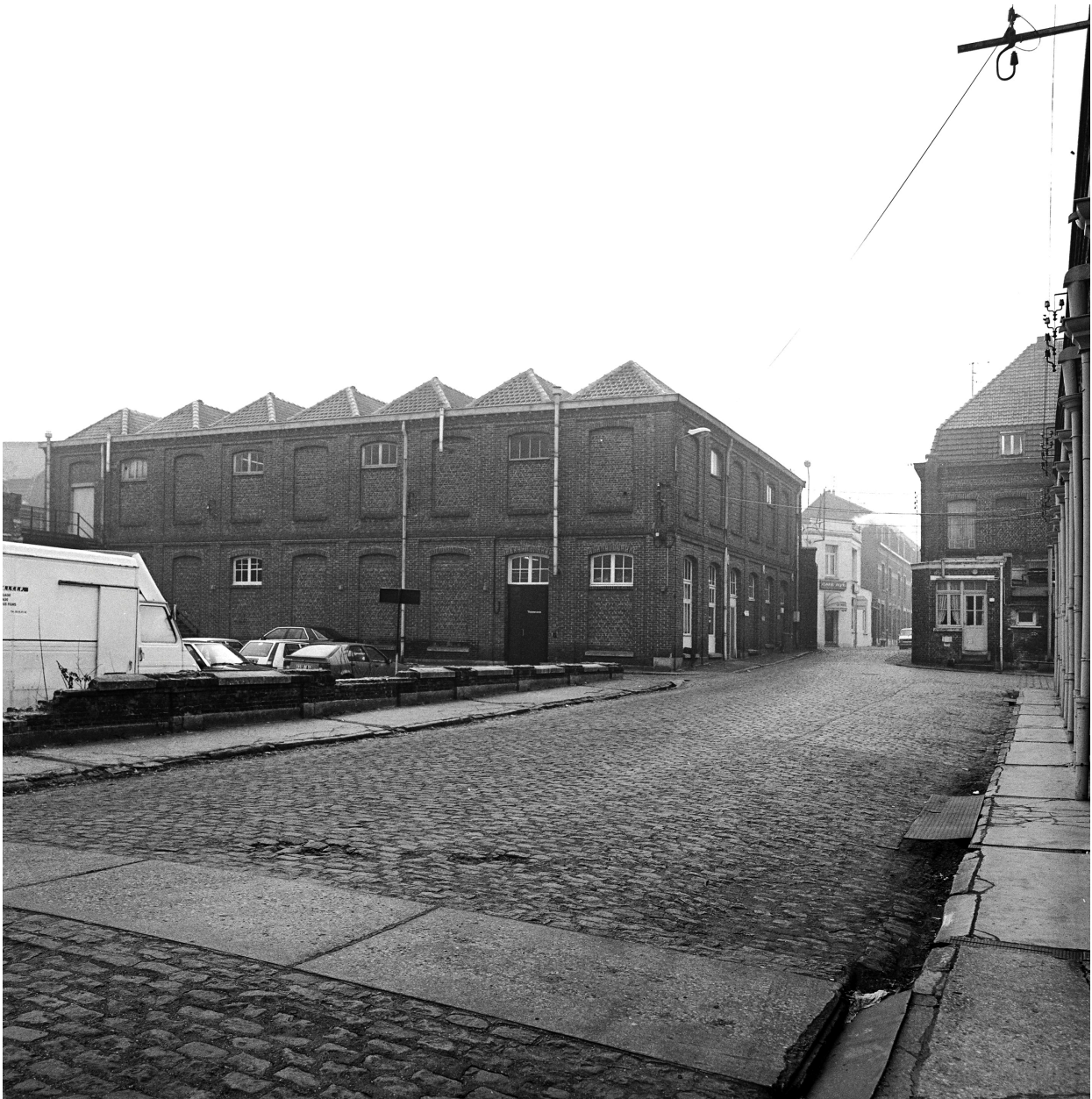
Magasin rue Victor-Hugo. Vue antérieure prise depuis la cour.
