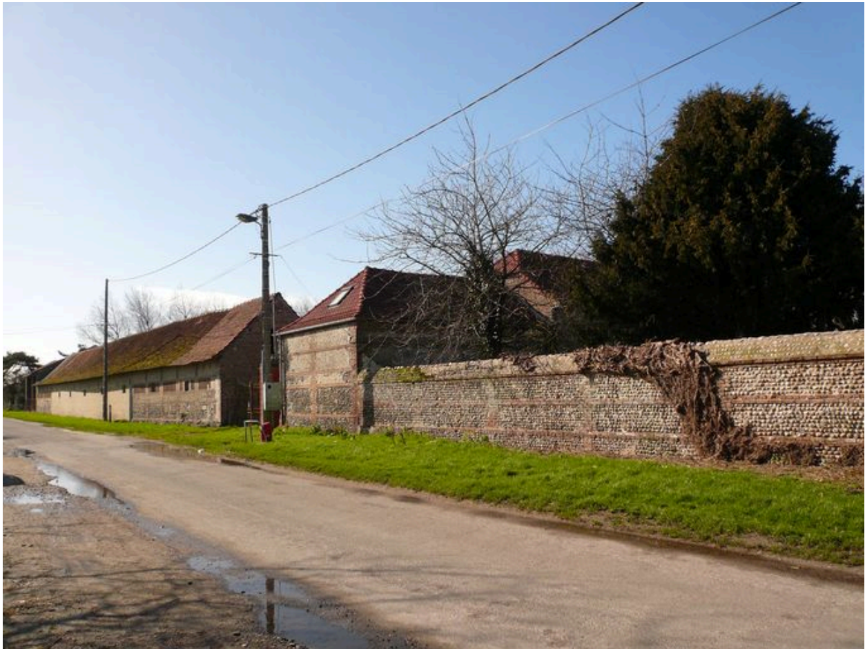
Vue générale extérieure depuis le nord.
