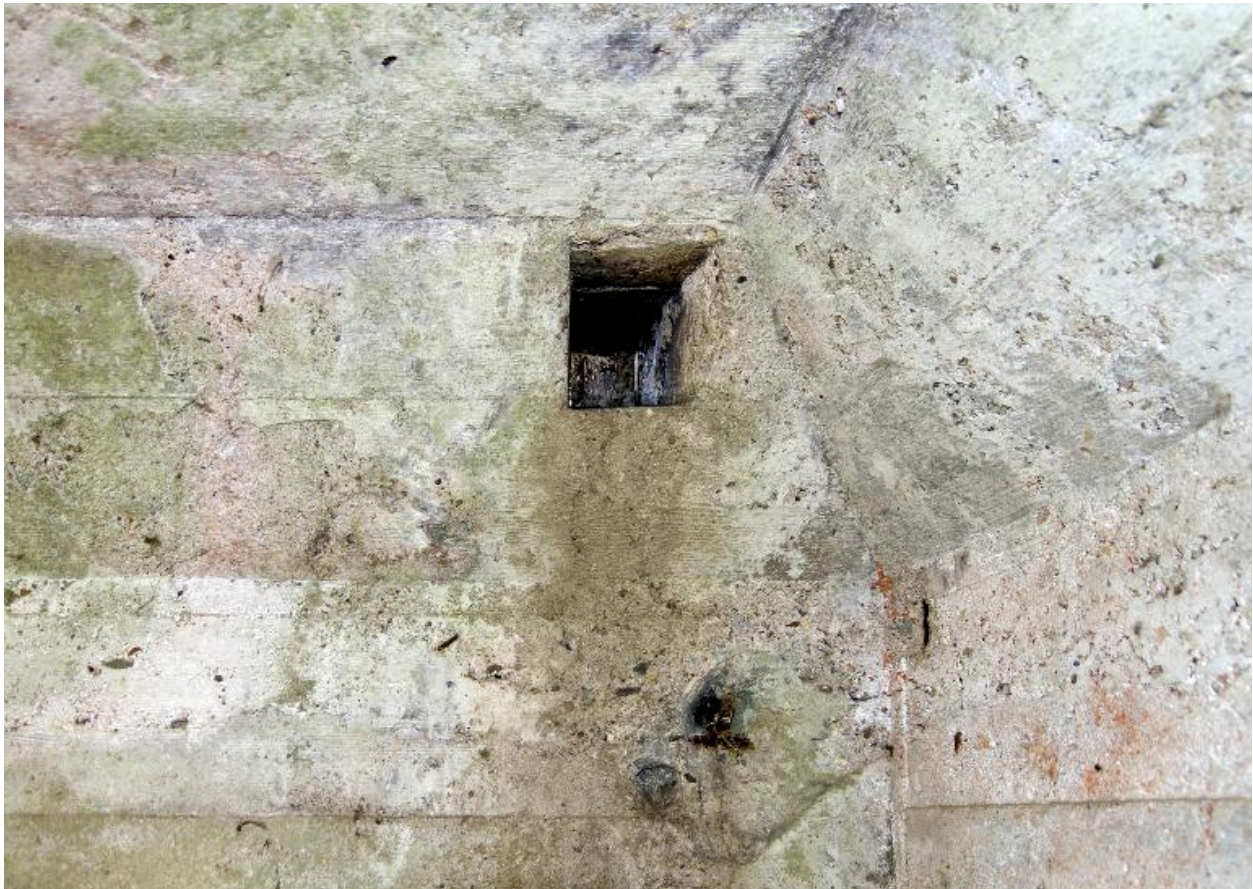
Guérite casematée (Bat. A). Depuis l'intérieur : Ouverture d'aération dans le mur ouest
