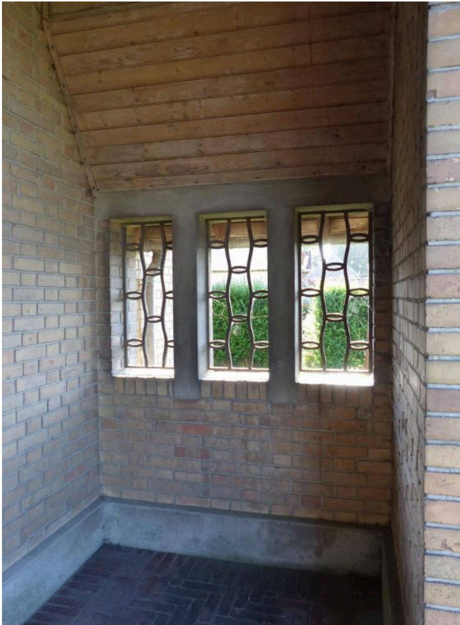
Vue de détail de l'intérieur du porche.
