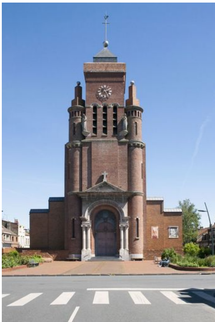
Élévation antérieure de l'église.
