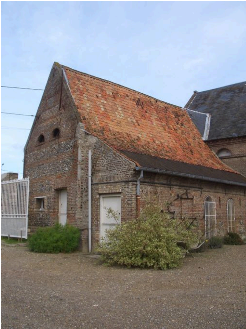
Vue des ateliers depuis la cour.
