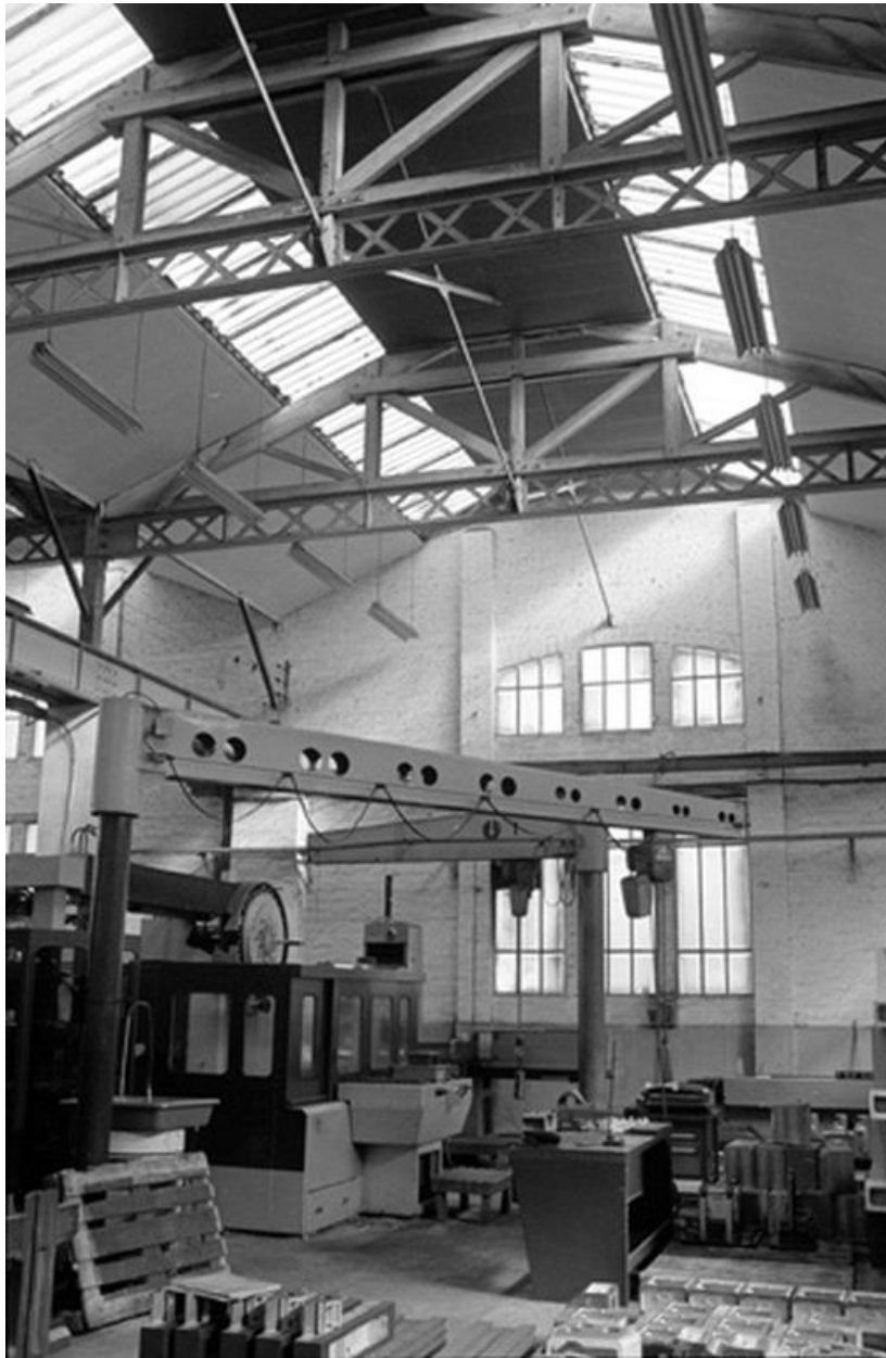
Atelier de fabrication, vue intérieure.
