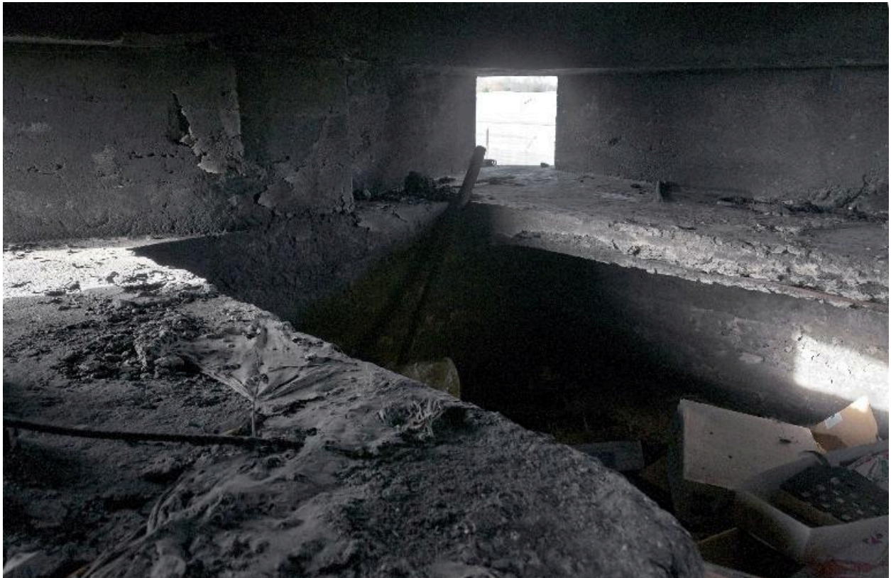
Vue intérieure des banquettes de tir nord et sud. Embrasure de tir nord-ouest
