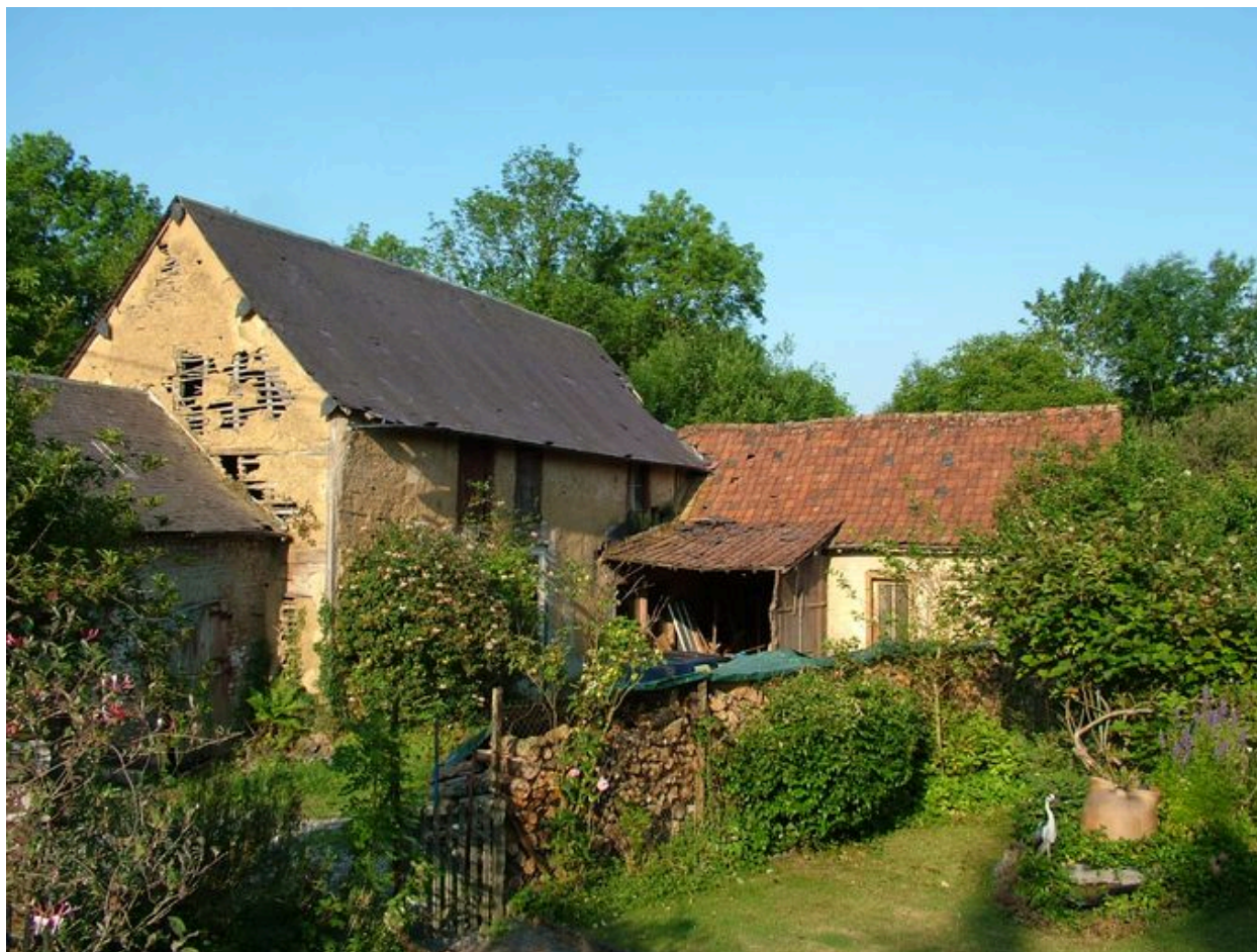
Vue générale des bâtiments d'exploitation.
