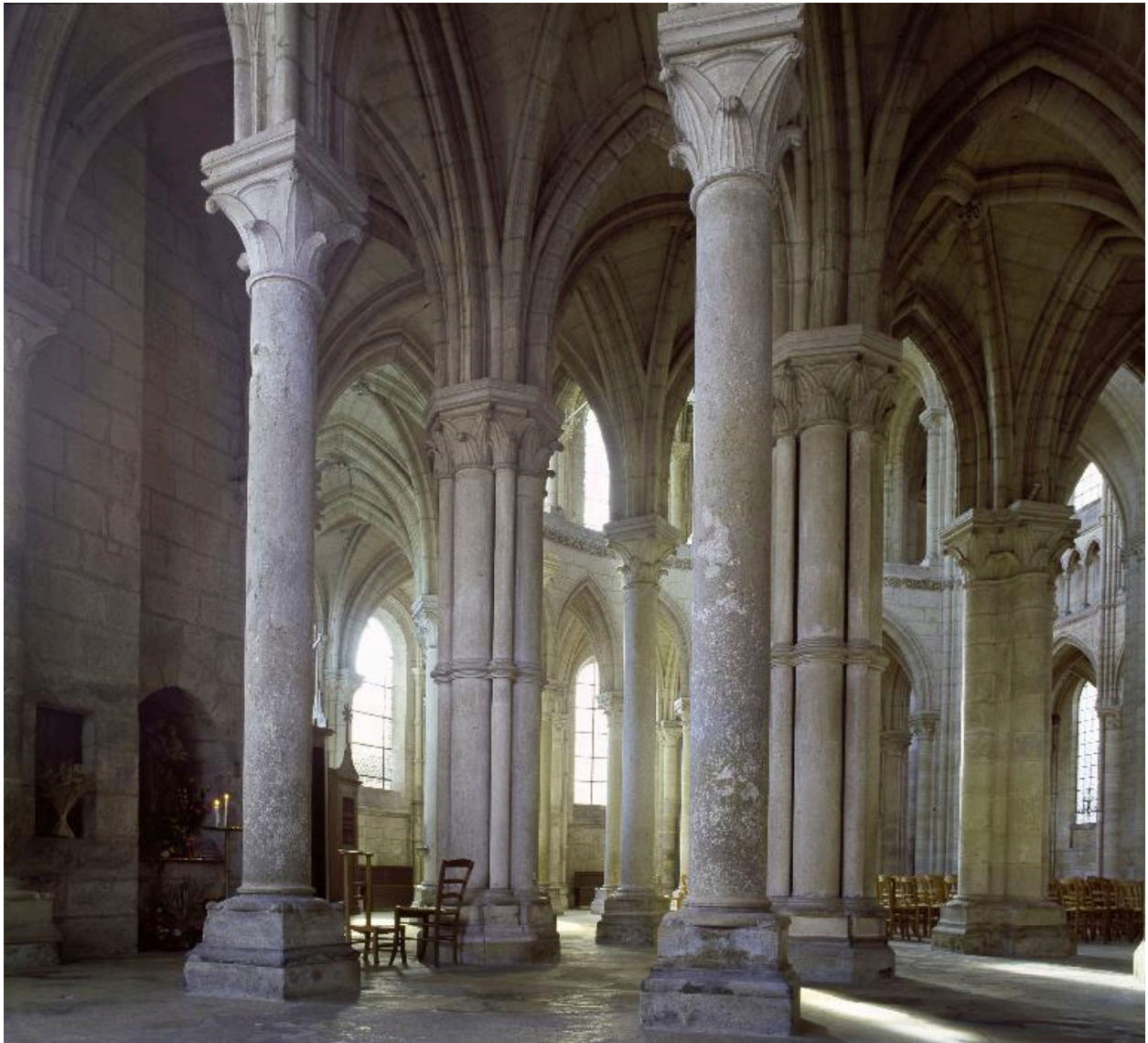
Vue du croisillon sud du transept, depuis la chapelle basse.
