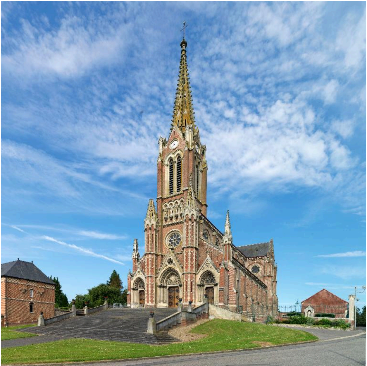
Vue d'ensemble extérieur sud ouest.
