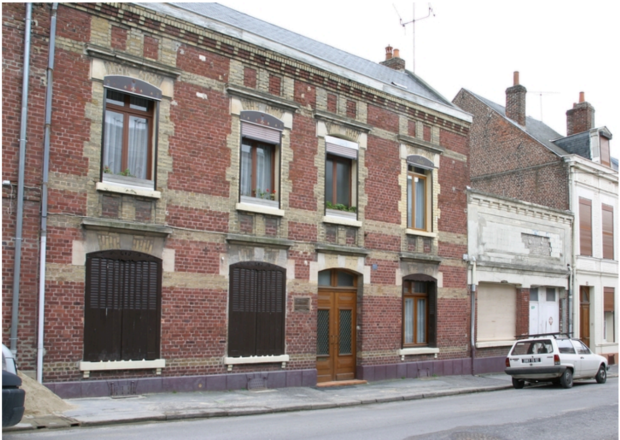
Vue de l'ancien logement patronal et des bureaux.
