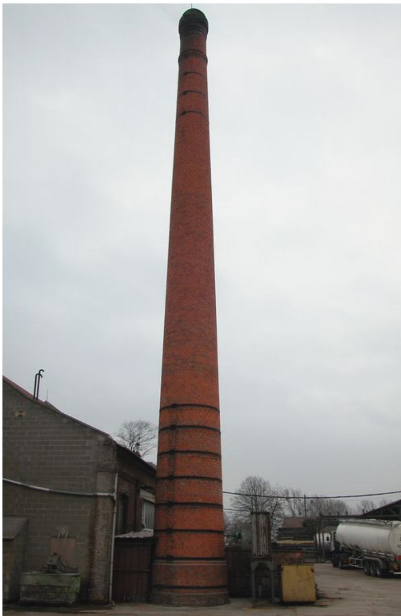
La cheminée de l'usine, vue d'ensemble.
