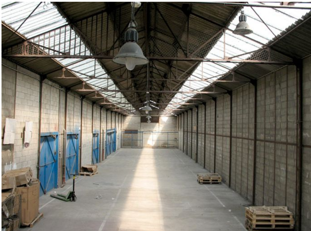
Bâtiment de stockage.
