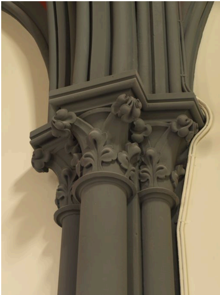
Chapelle, intérieur : chapiteau
