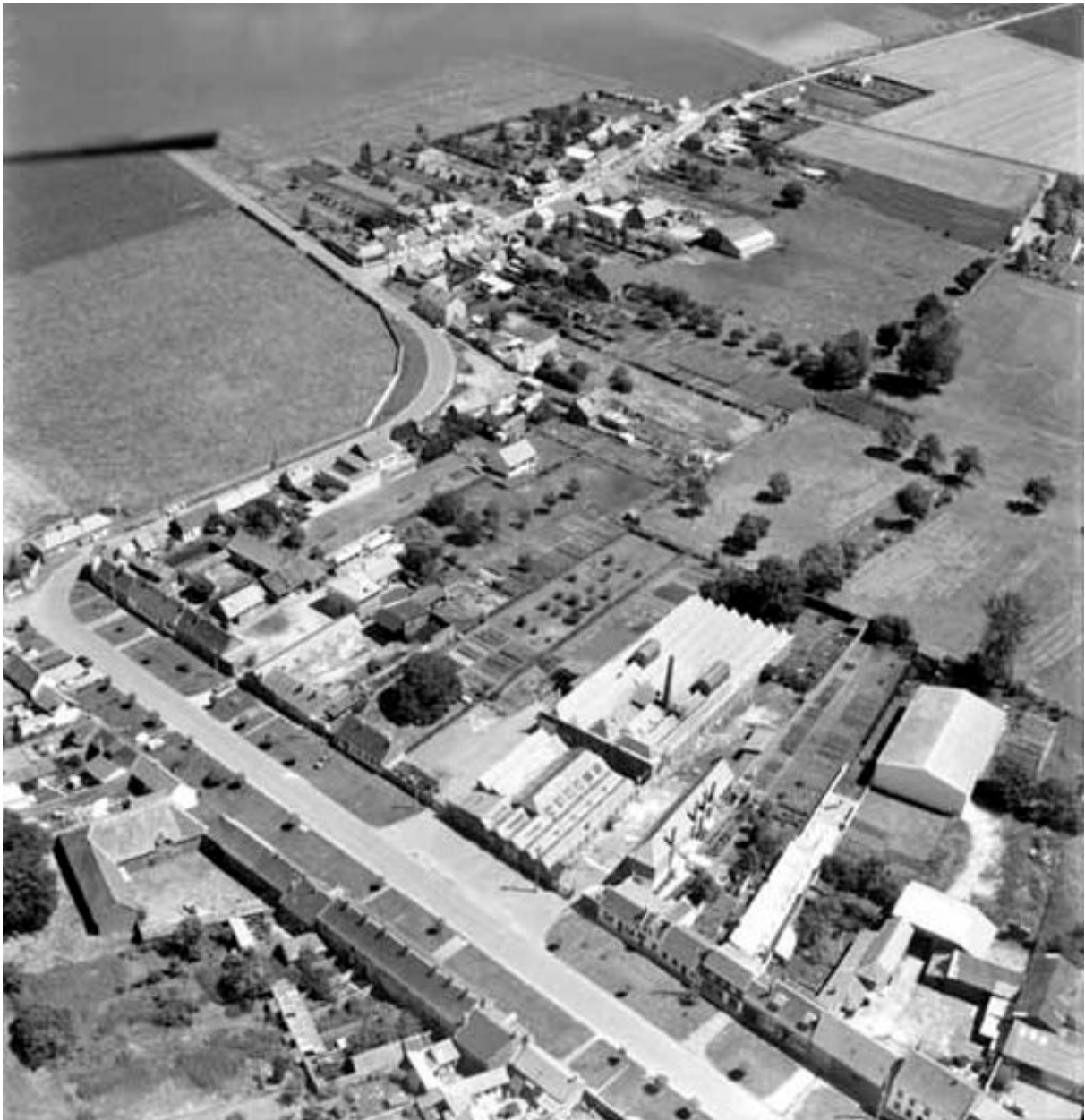
Vue aérienne, flanc sud-ouest.
