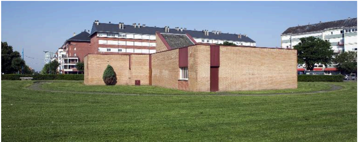
Élévation latérale gauche et façade postérieure.
