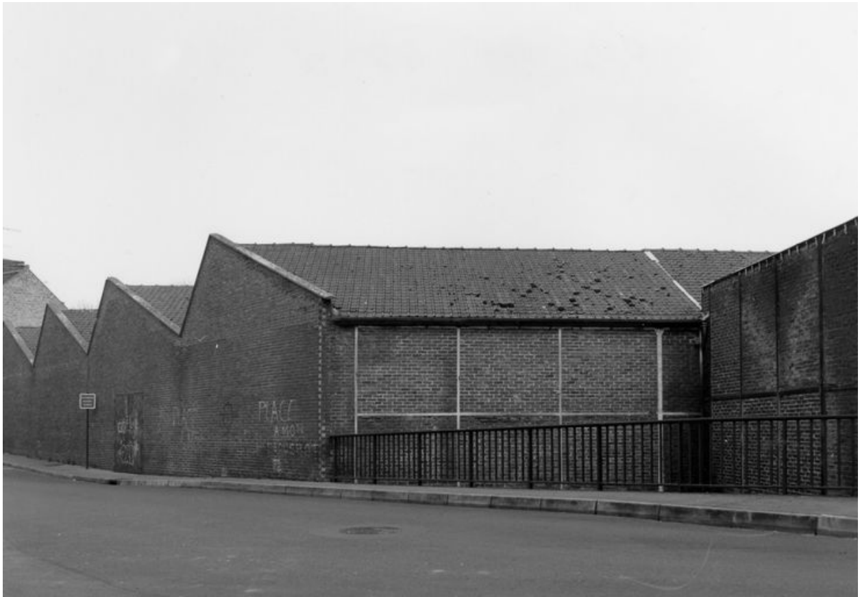
Les anciens ateliers de teinture bordant la rue des Teinturiers.
