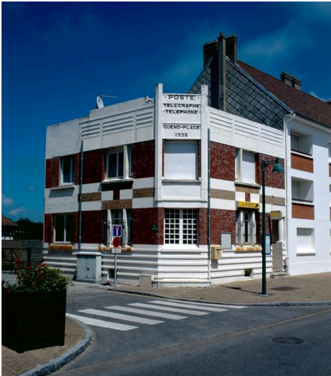
Vue d'ensemble sur le pan coupé.
