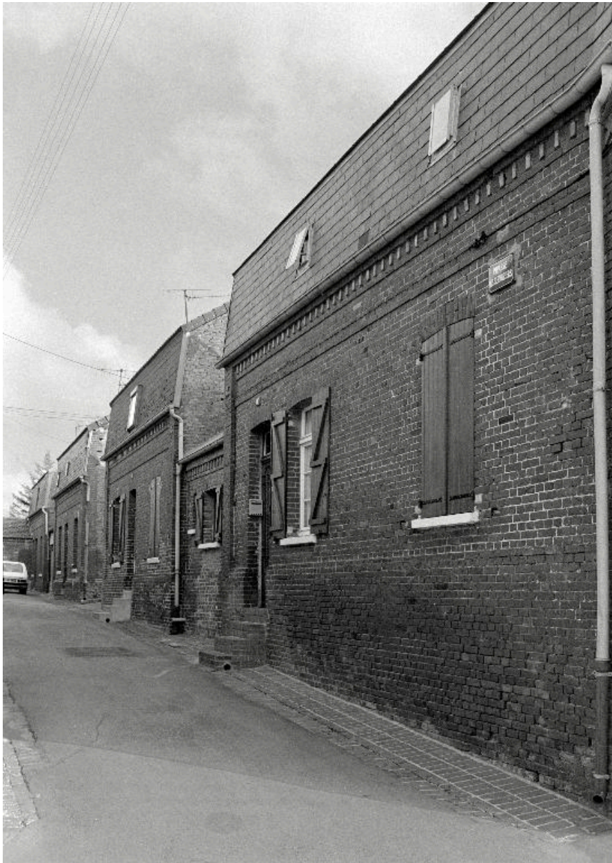
Vue de la rive est de l'impasse des Serruriers, en 1990.
