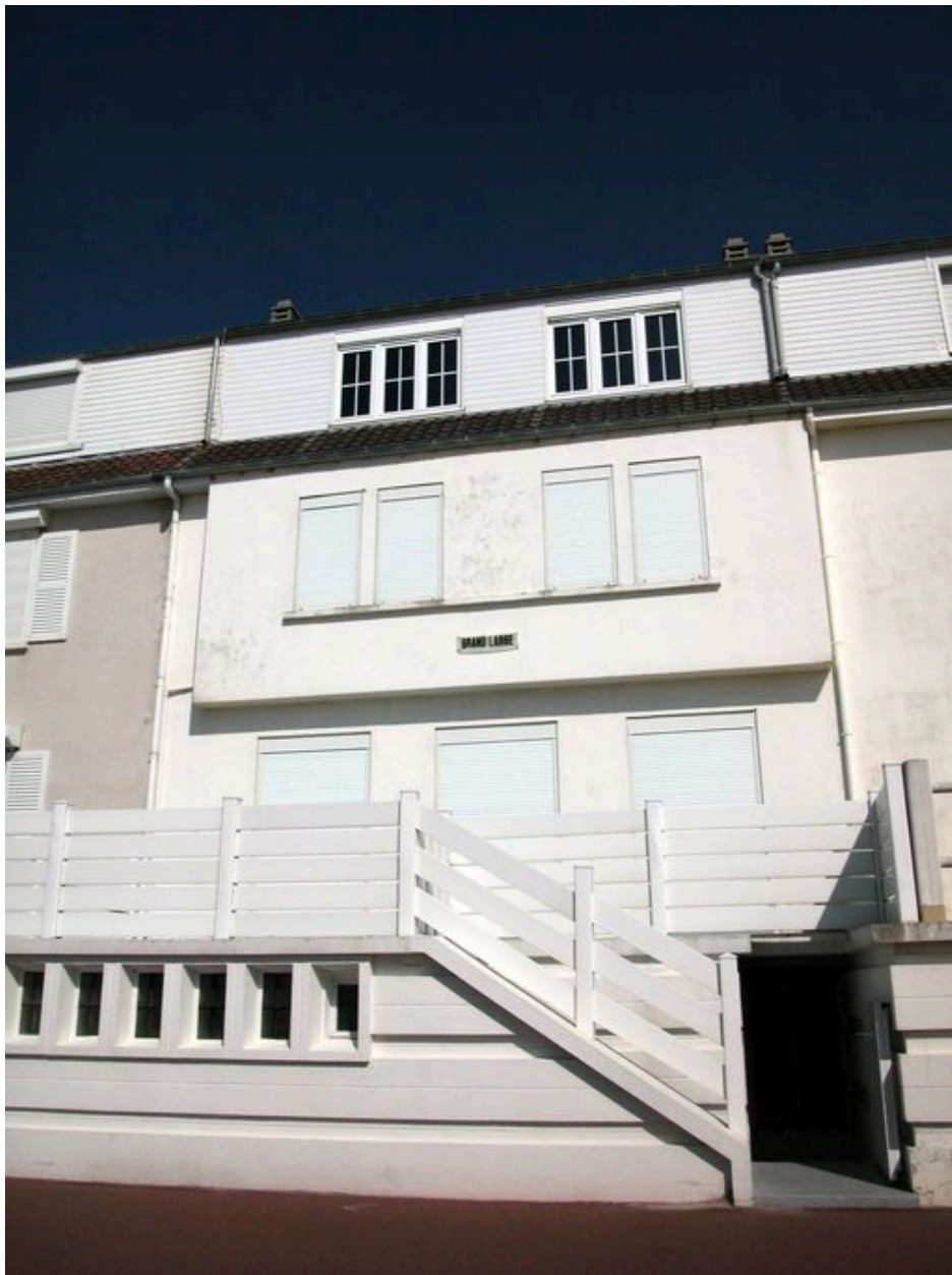
144 boulevard maritime sud (Grand Large), façade sur mer.
