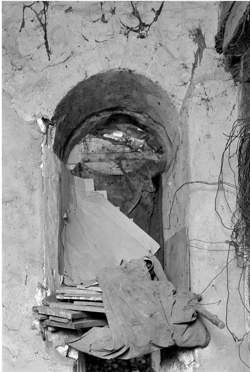
Baie du rez-de-chaussée : vue de l'intérieur.
