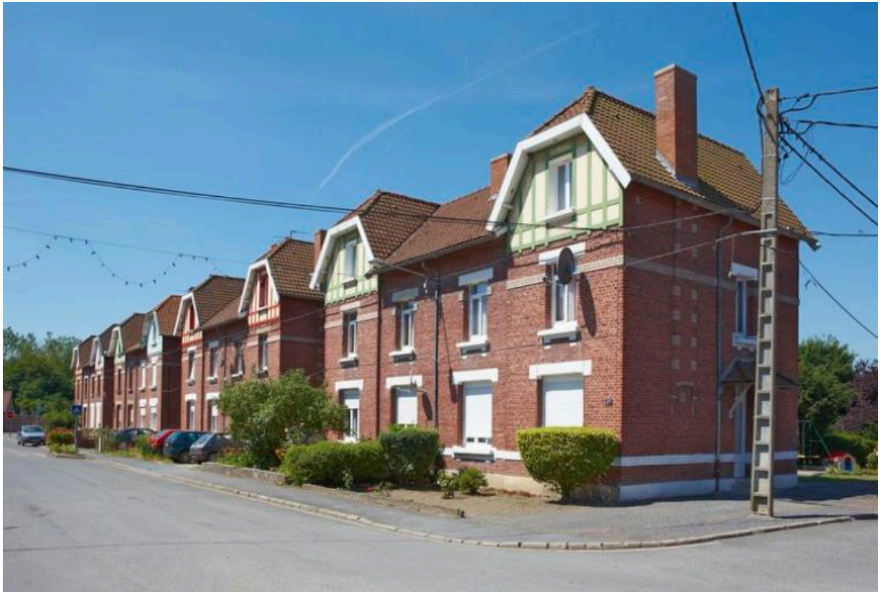
Vue générale d'un alignement de la cité.
