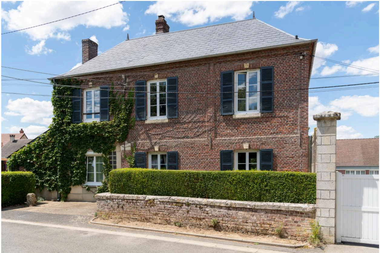
Demeure n°9 rue de l'École, vue depuis l'est.
