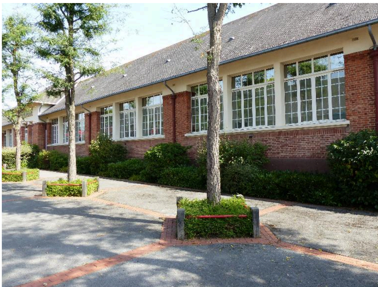
L'ancienne école de garçons (à l'est), vue depuis la rue centrale.
