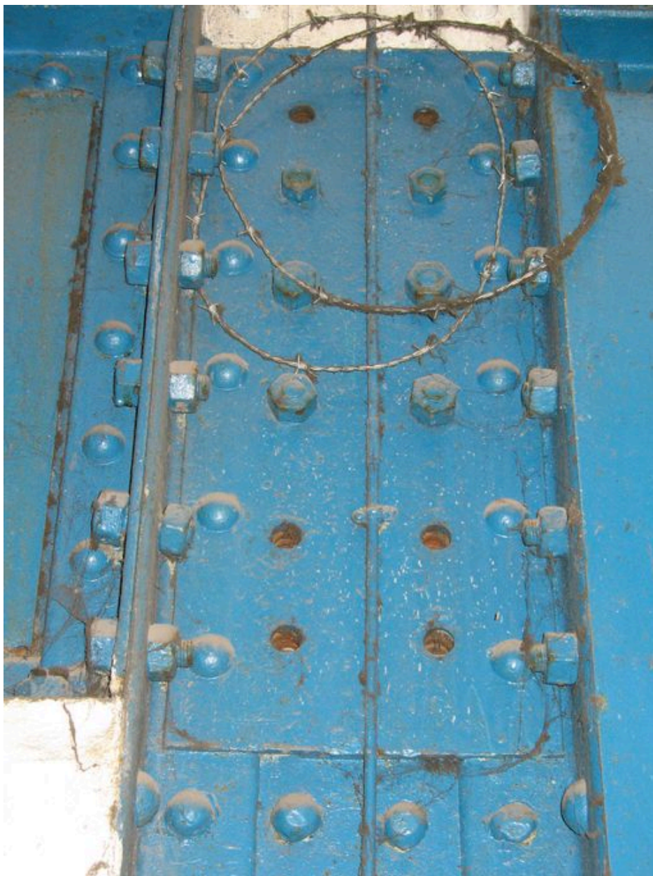
Poutrelle pleine rivetée de la structure.
