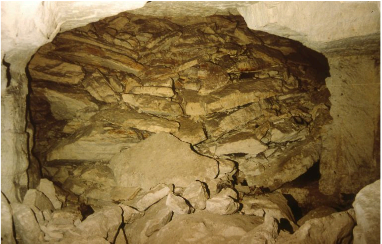
Vue d'une galerie obstruée.
