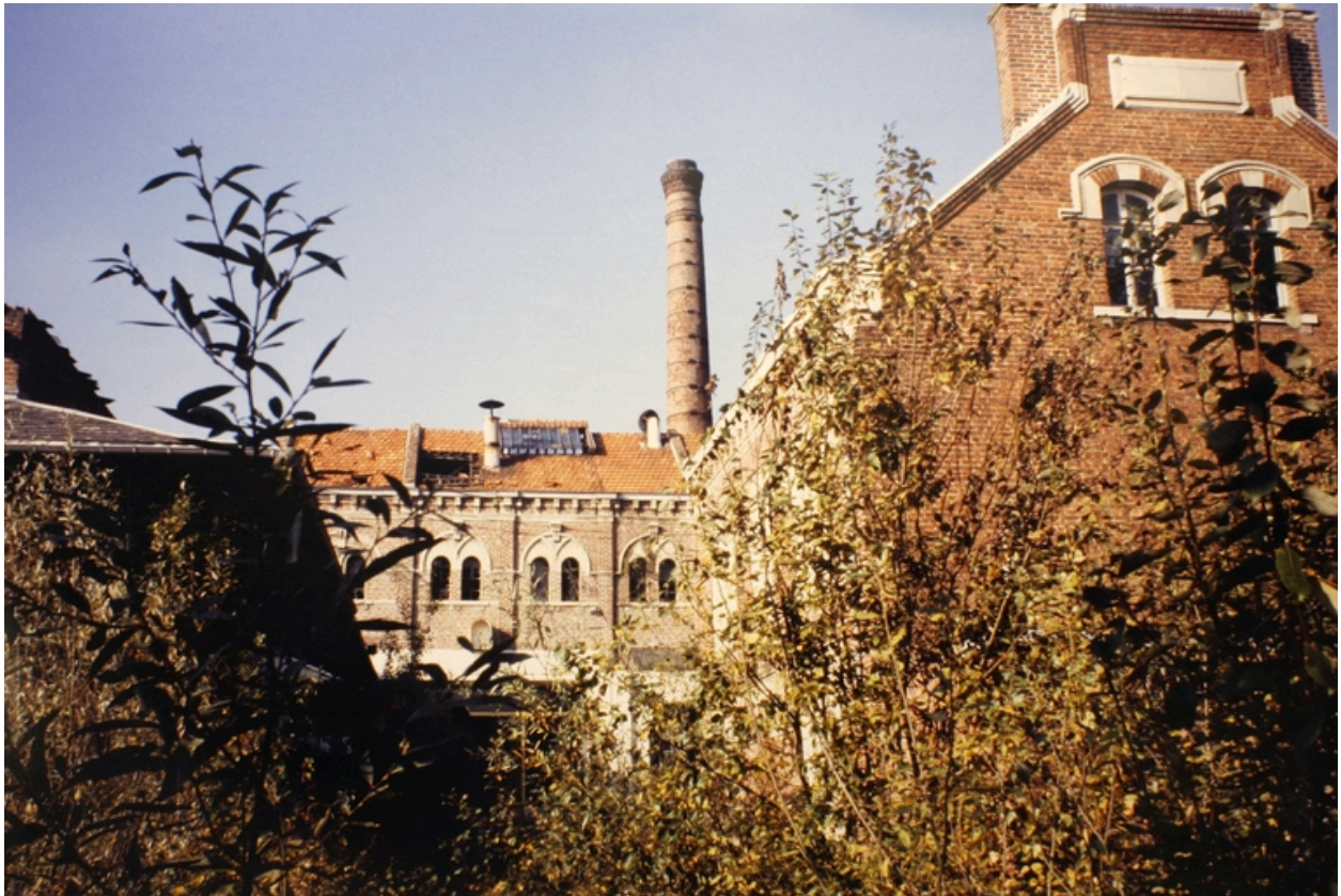
La friche industrielle de la brasserie avant la démolition (BM Saint-Quentin).
