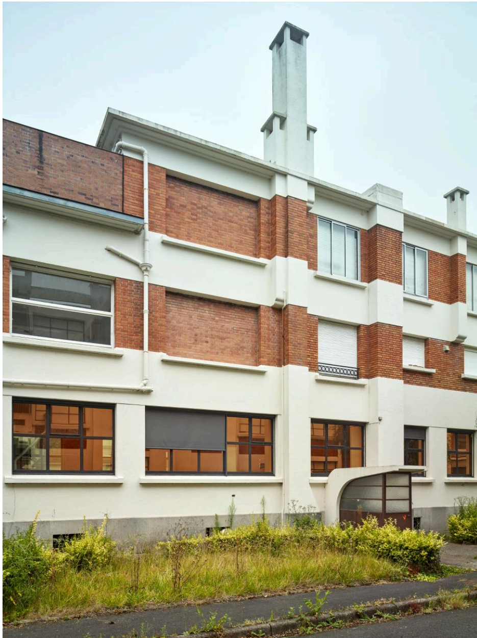
Bureaux et logements (E). Elévation postérieure. Descente de cave protégée d'une marquise.
