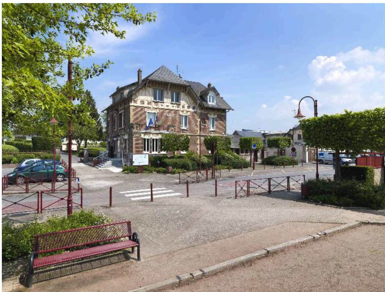
Vue générale depuis le sud-ouest.
