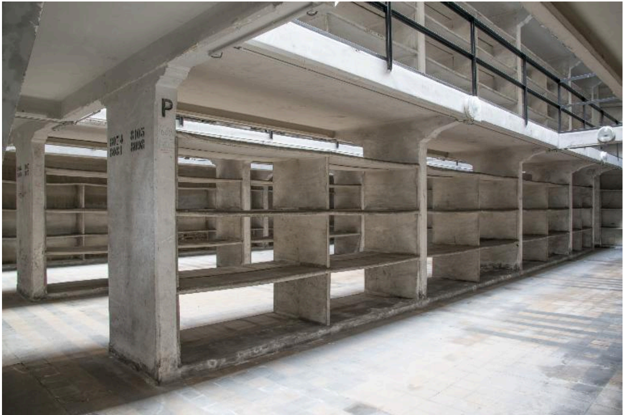
Bâtiment du dépôt, rez-de-chaussée : vue des vaisseaux 3, 2 et 1 vers l'est. Sur le pilier, au premier plan, la lettre P en céramique noire est un élément de la signalétique d'origine.
