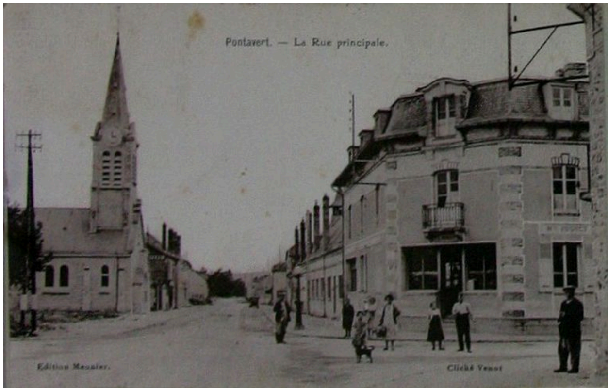
Vue de la rue Principale, après la reconstruction (coll. part).
