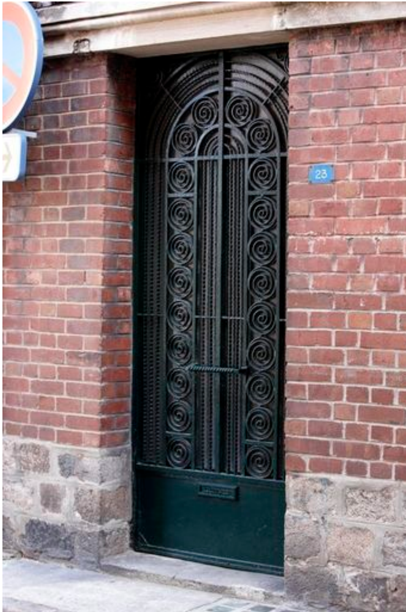
Porte en fer forgé aux motifs à spirales, au 23 rue du Fer-à-Cheval.
