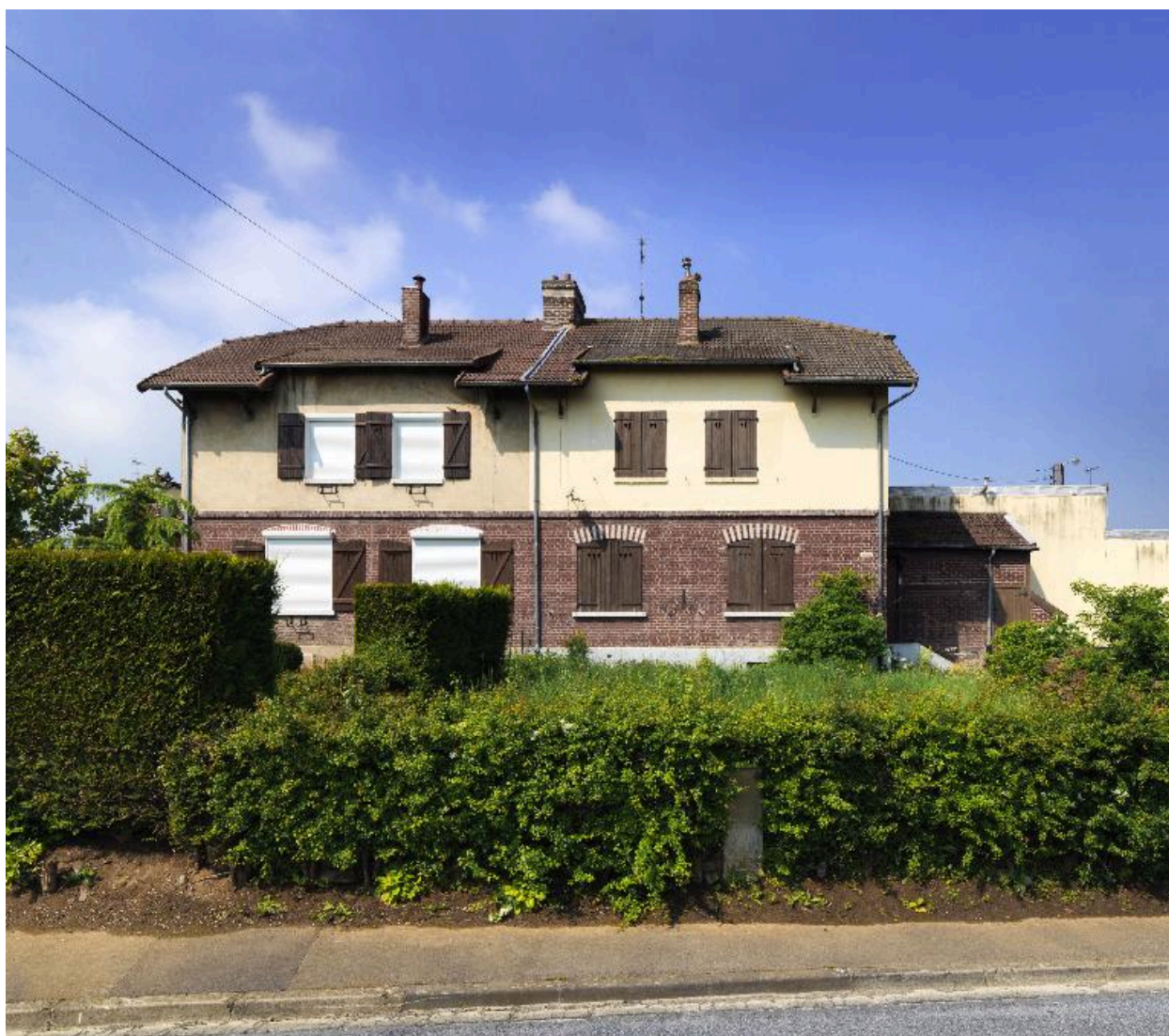
Maison de type B, à quatre unités d'habitation (8-10 rue Pasteur).
