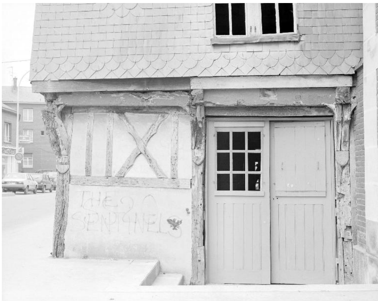
Élévation sud, détail.
