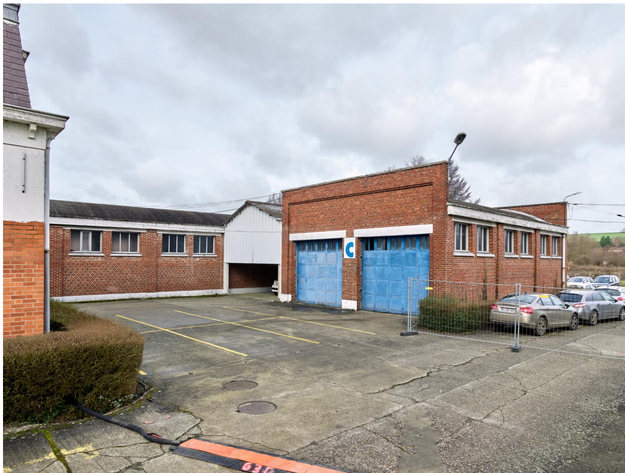
Bâtiment technique et logistique à l'entrée de l'usine (bâtiment C).
