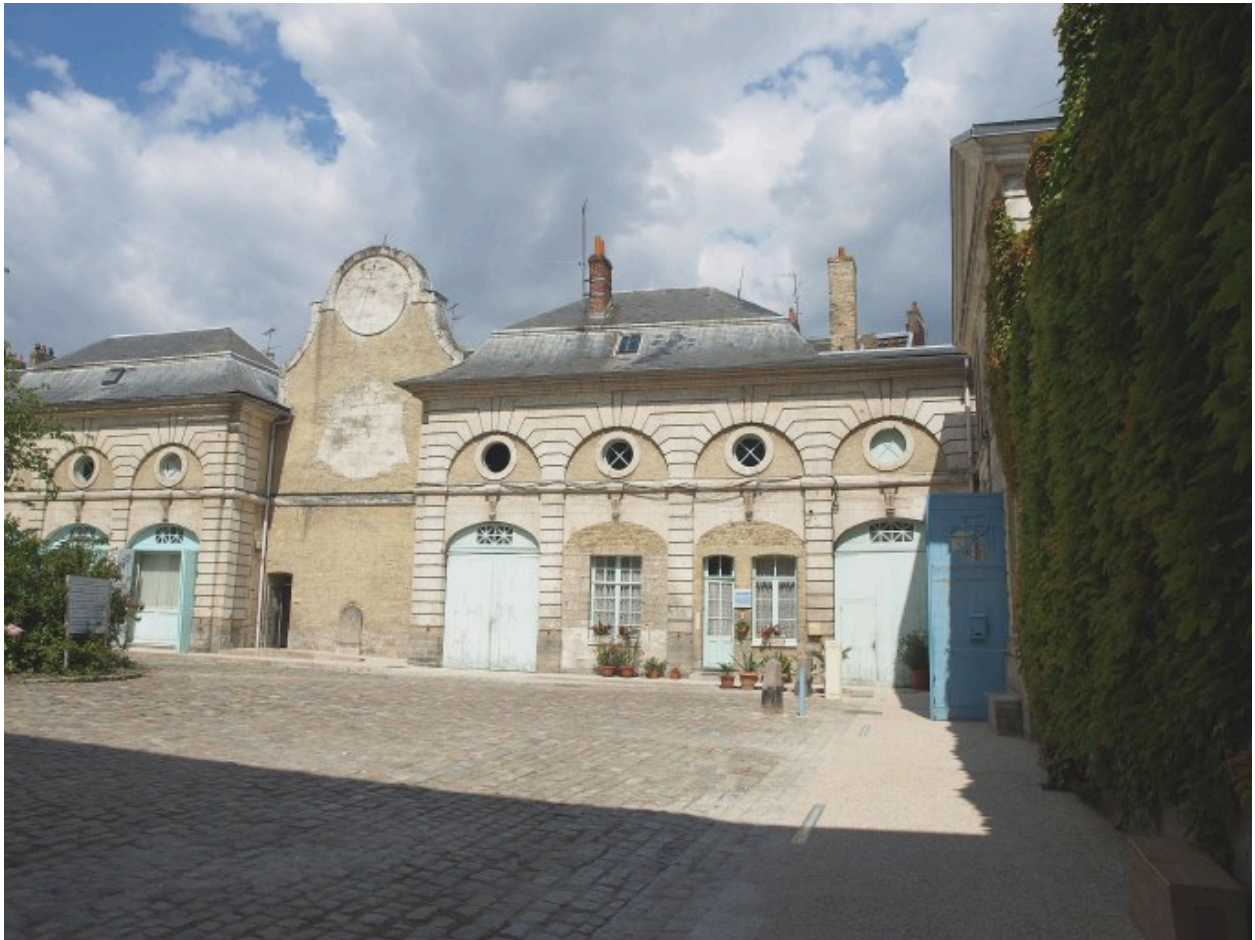
Vue sur les bâtiments donnant sur la rue des tribunaux, vus depuis la cour
