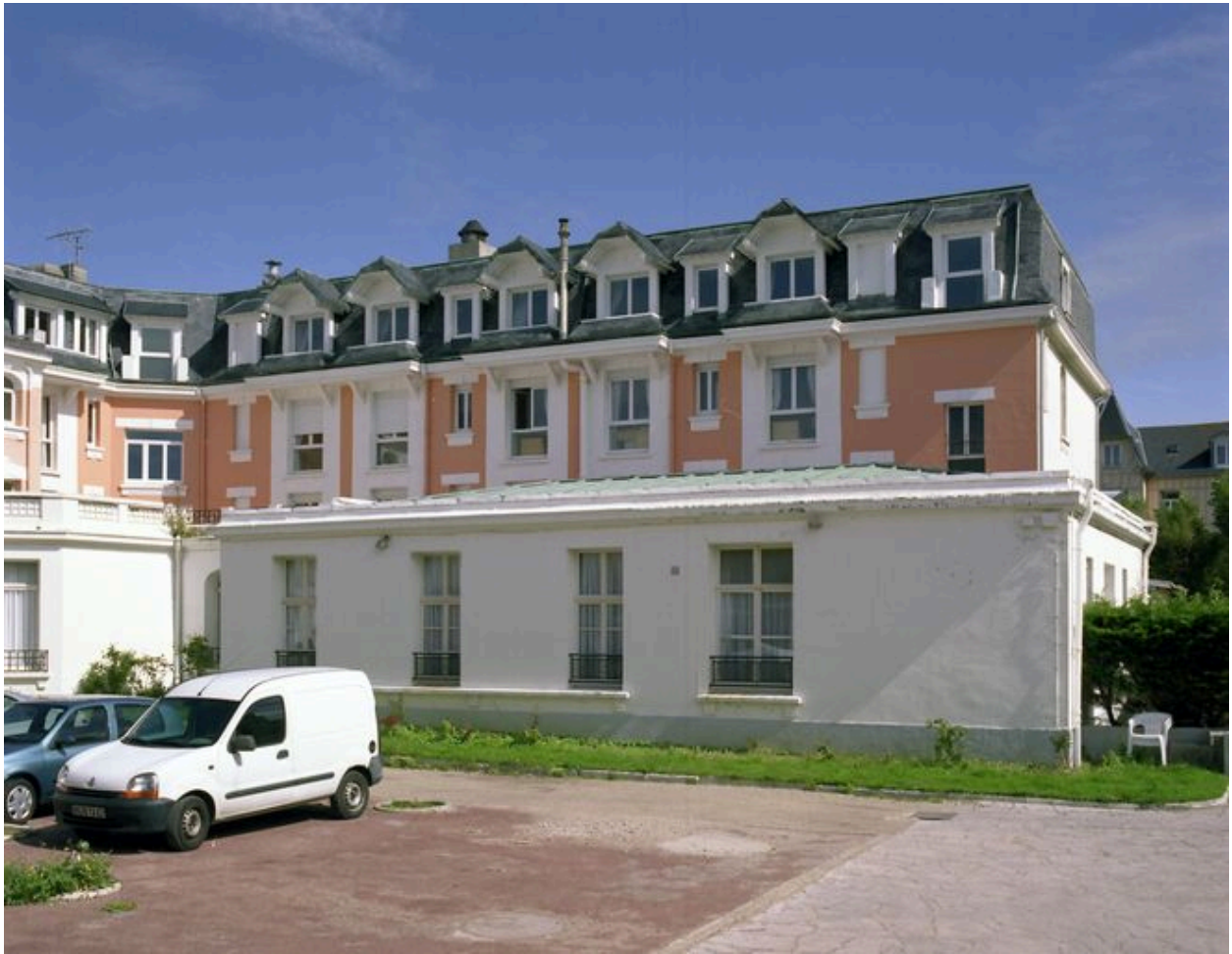
Corps de logis donnant sur la rue Eugène-Trigoulet, élévation postérieure.
