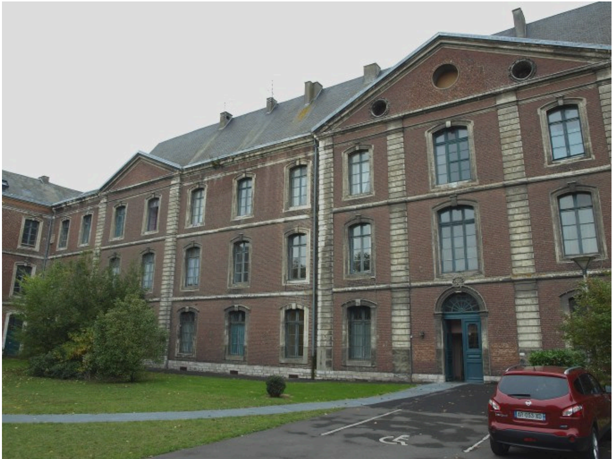
Façade sur cour du bâtiment ouest
