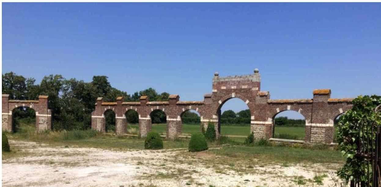
Vue de la cloture au sud de la cour.
