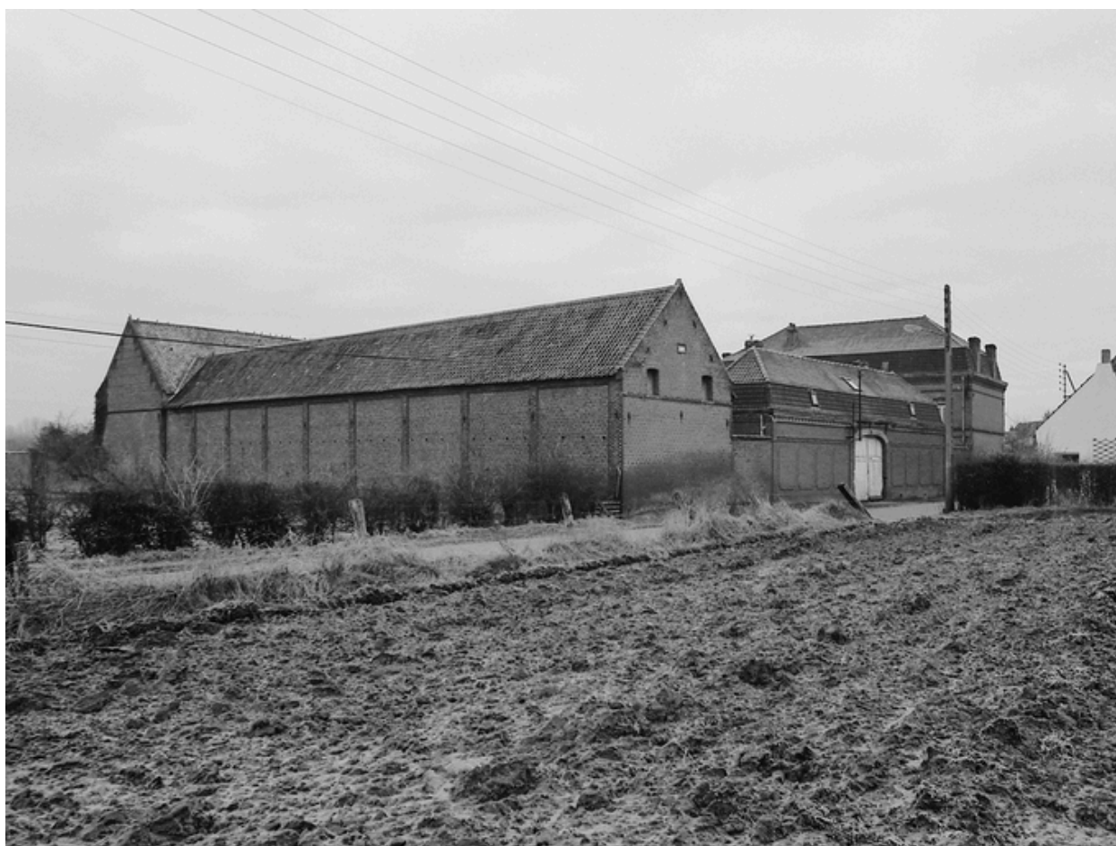
Ferme, rue Neuve.
