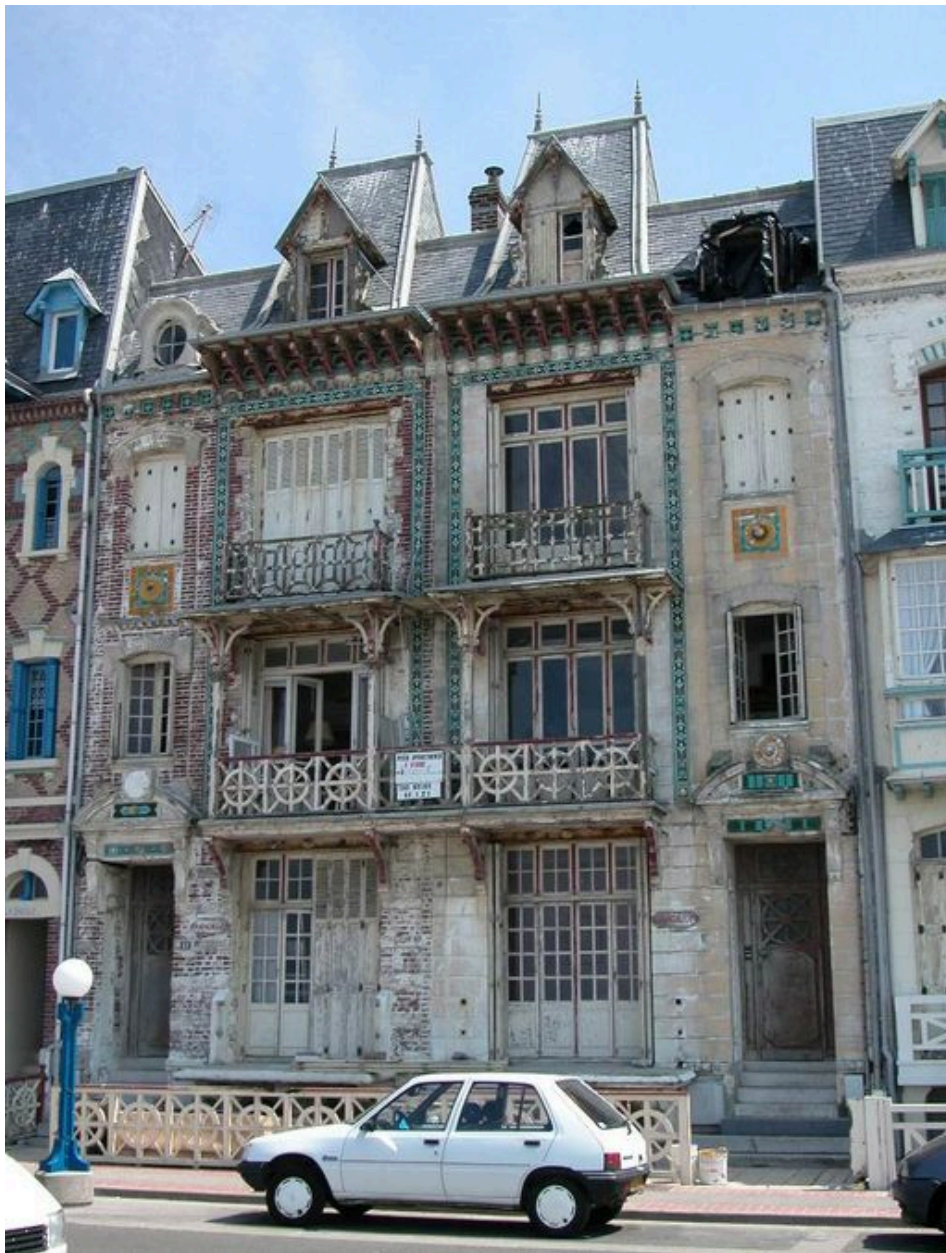
Vue d'ensemble depuis l'esplanade, état avant restauration (2003).
