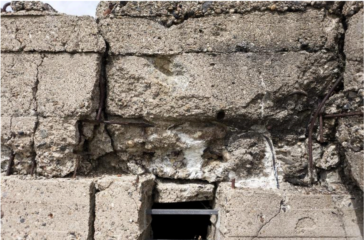
Casemate (f), détail du ferrailage
