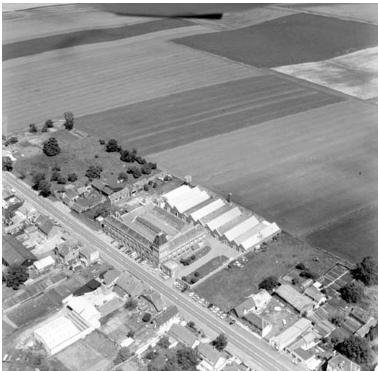
Vue aérienne, flanc sud-ouest.
