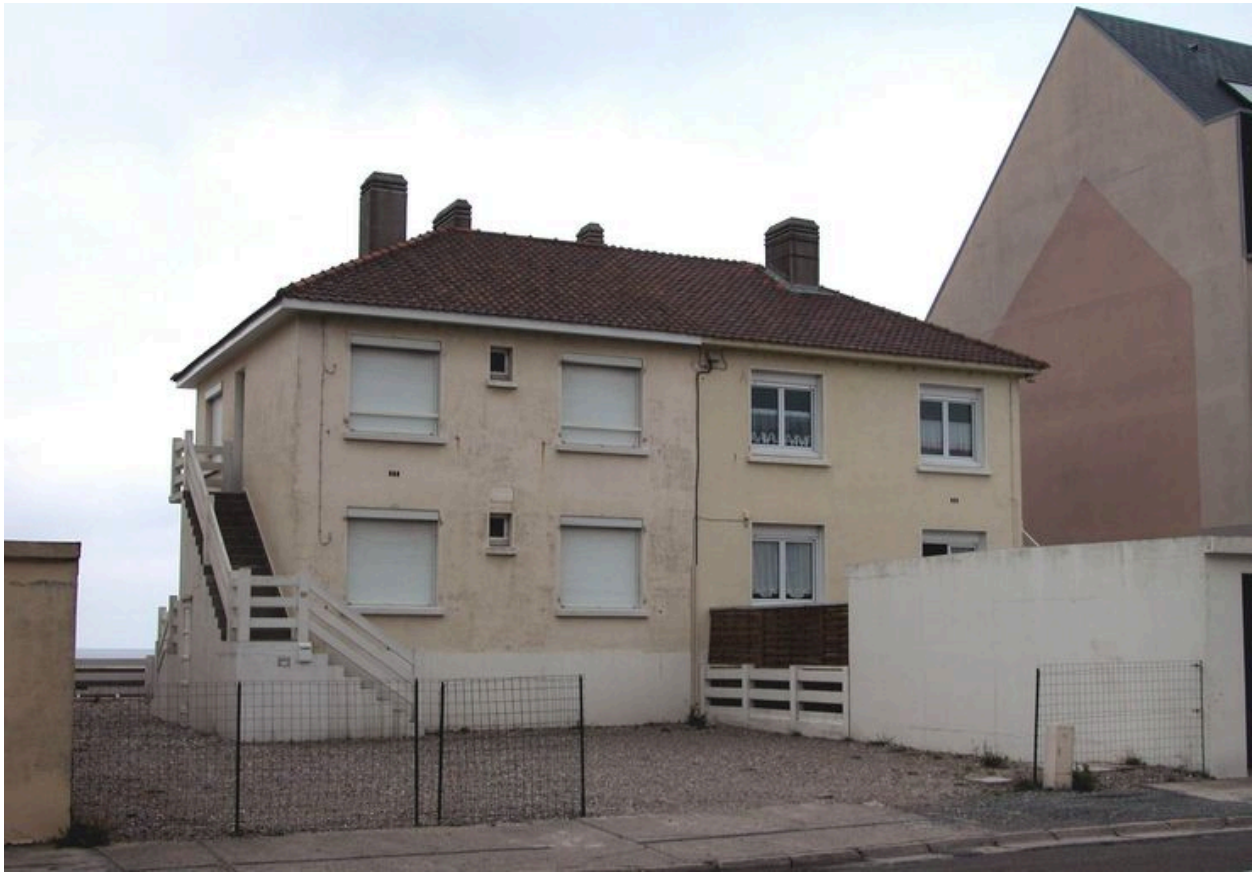
Vue d'ensemble, élévation postérieure.
