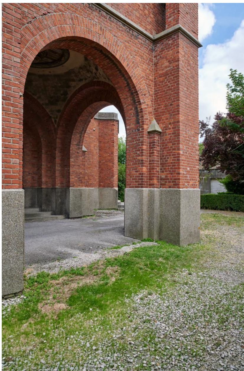
Le porche sous le clocher, face nord.
